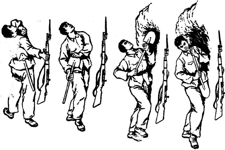
图 3-108 敌火下构筑单人掩体
